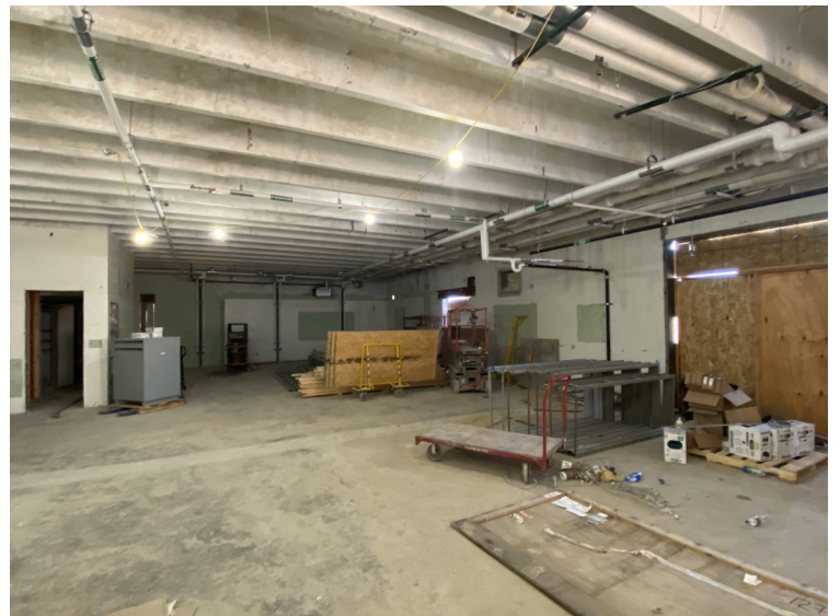
Area G Level 2—MEP Demo
